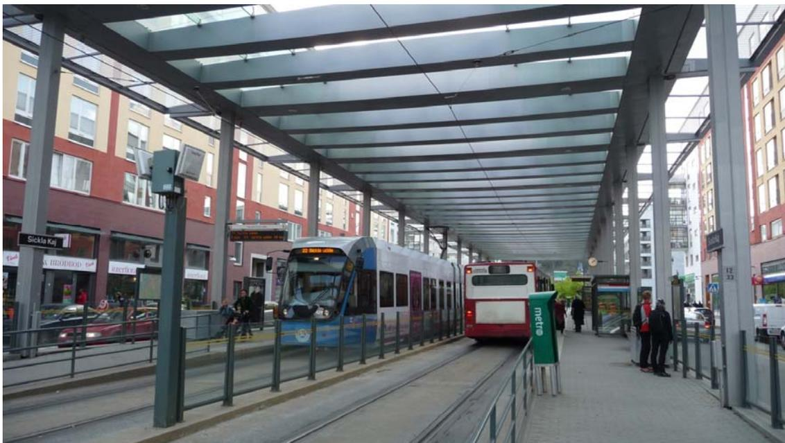
Note : Malgré une structure métallique couvrant les quais et la plate-forme, seuls les quais sont couverts par un revêtement vitré.
